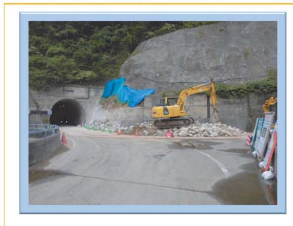
○工事の状況 (堤体左岸法面)
