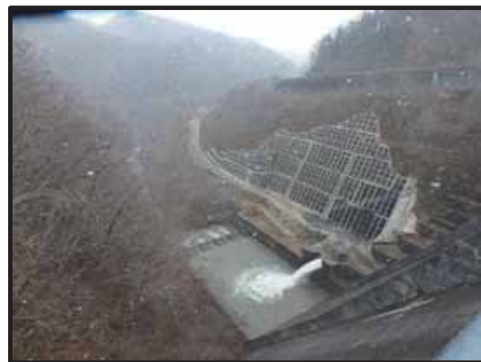
令和元年度工事（工事用道路） 完成した工事用道路（令和元年12月）
