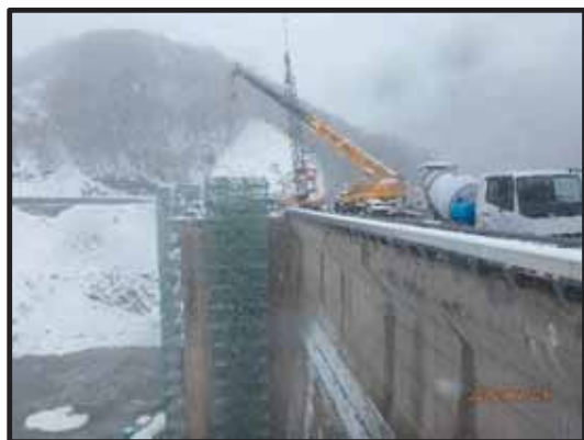
令和元年度工事（取水施設） 塔内へのコンクリート打設（令和2年2月）
