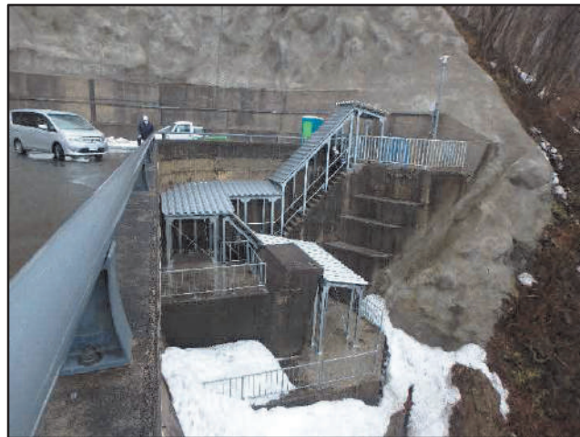
堤体左岸シェルター据付状況 (3月)
