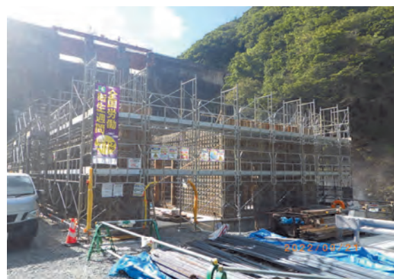
小水力発電施設の上屋工事（近景）
