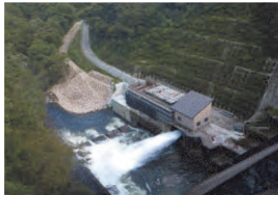
放流施設上屋（手前）と工事中の発電施設上屋（奥）
