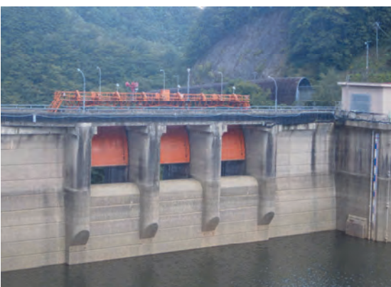
改修前の洪水吐設備
