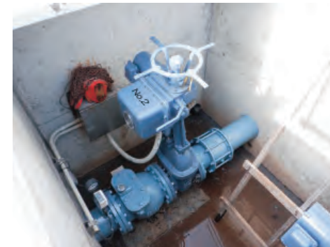
尾花堰揚水機 (水中ポンプ整備 他)
