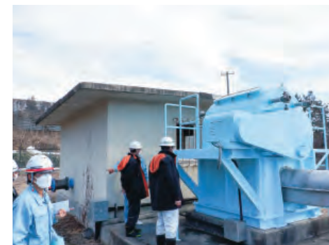
狼沢補水除塵機 (サイクロ減速機更新 他)
