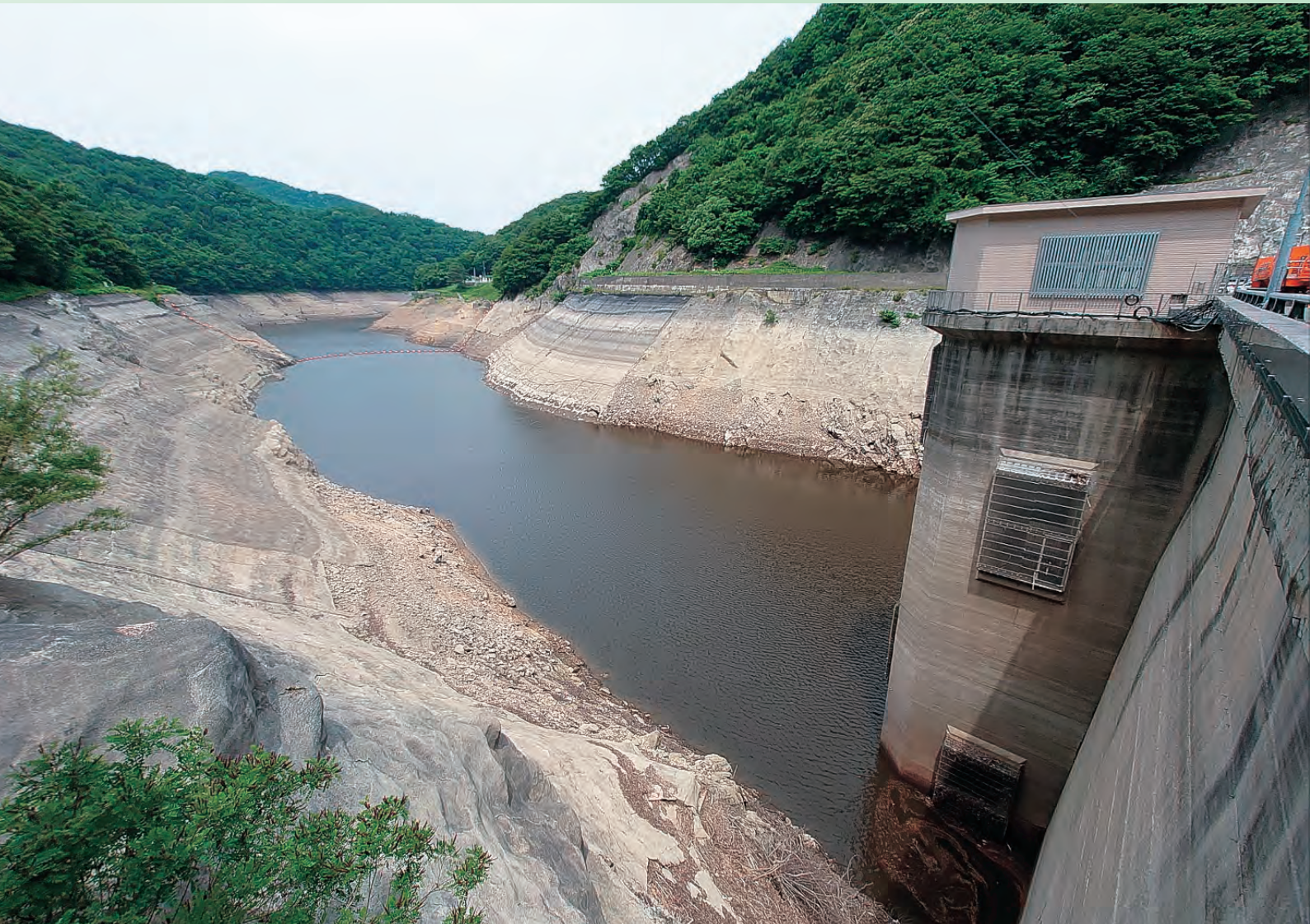
渇水により貯水率5%となった豊沢ダム（6月21日現在）
