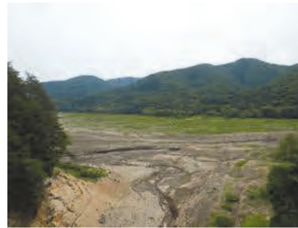
豊沢ダム上流部
