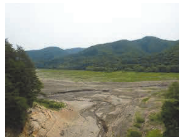
豊沢ダム上流部
