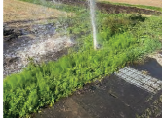
給水栓破損事故
