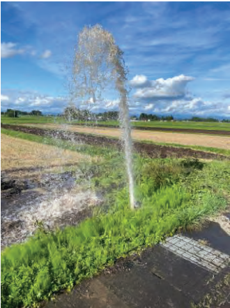
給水栓破損事故
